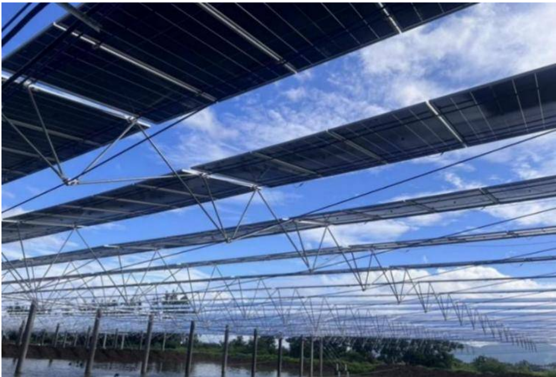
图 7.3-3 钢管桩+柔性钢桁架方案示意图
