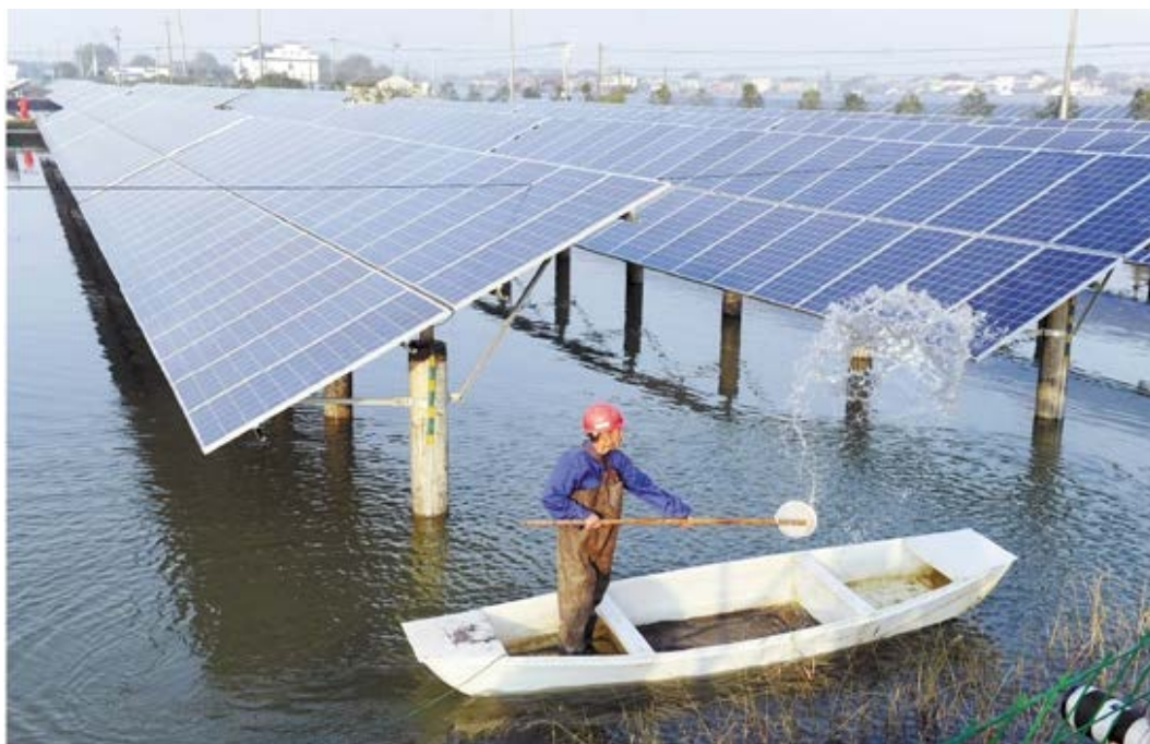
图 7.3-2 PHC 桩+钢支架方案示意图
