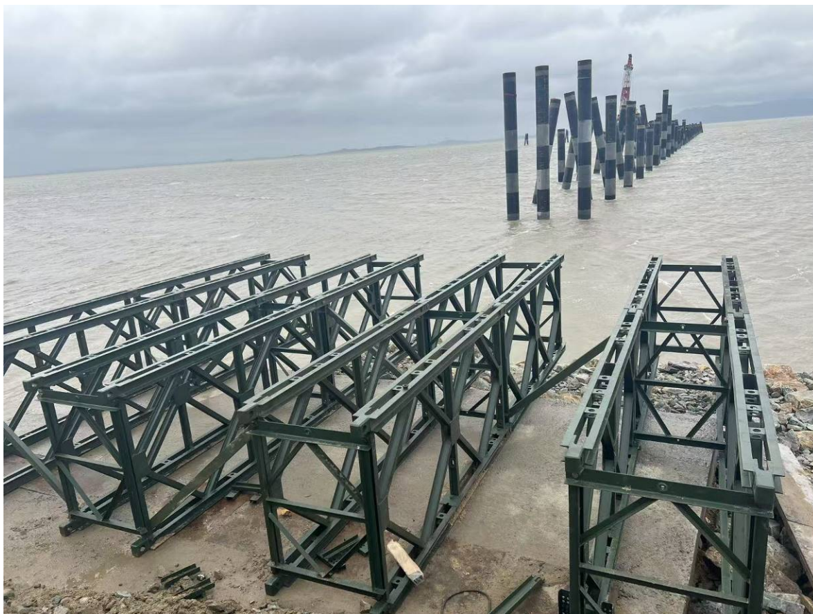
图 2.4-1 现状施工情况
